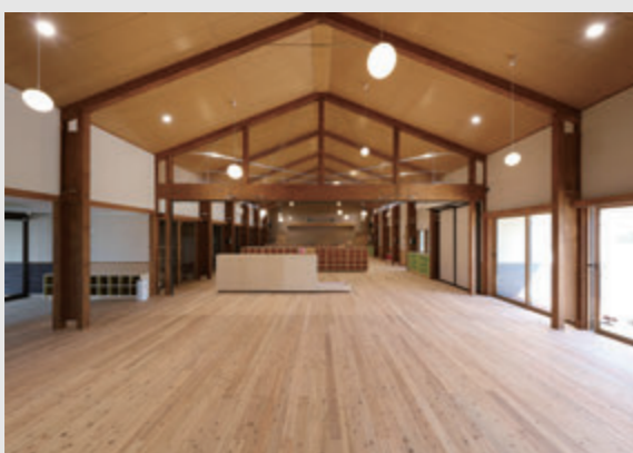
10m以上の大開口を取りながら壁量と勾配天井を可能にした工法。
