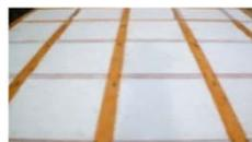
床(根太床) AclearUボードNT 24K 80mm
